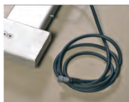
Защита кабеля от повреждений
